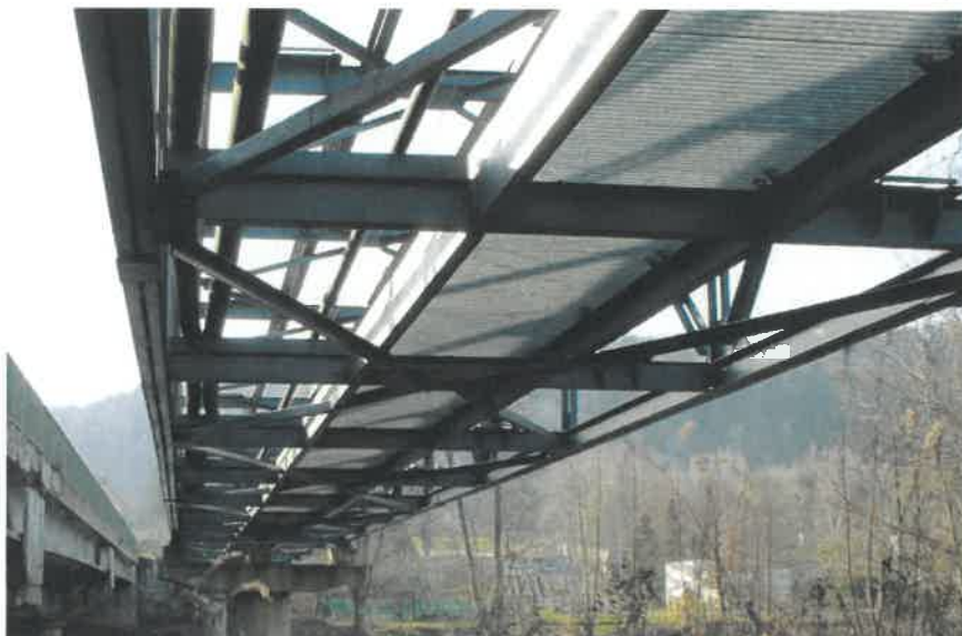
Obrázek 7 – Podhled nosné konstrukce po provedené opravě – Stav v roce 2020
