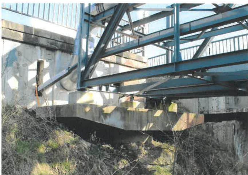
Obrázek 8 – Detail uložení nosné konstrukce na krajní podpěře a přechod na technologickou komoru
