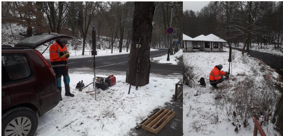
Realizace sond dynamické penetrace a maloprofilové jádrové sondy
