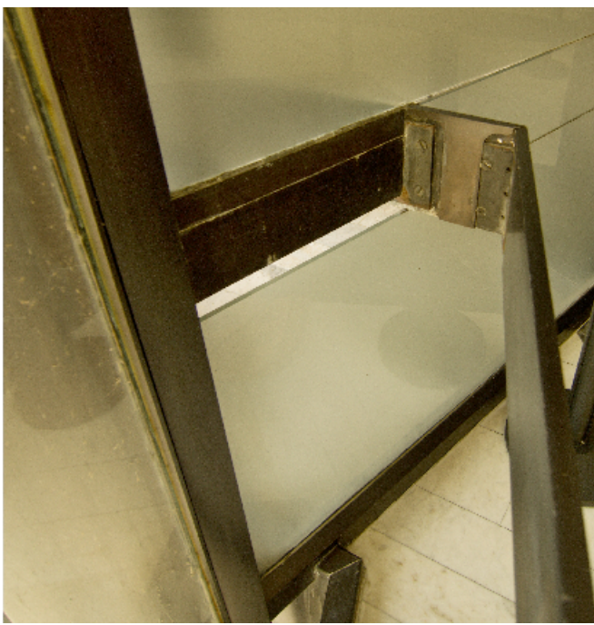
Stěna A- det, 2.NP Pohled na část prosklení stěny, do které zasahuje ocelové ztužující madlo, procházející oběma halami.
