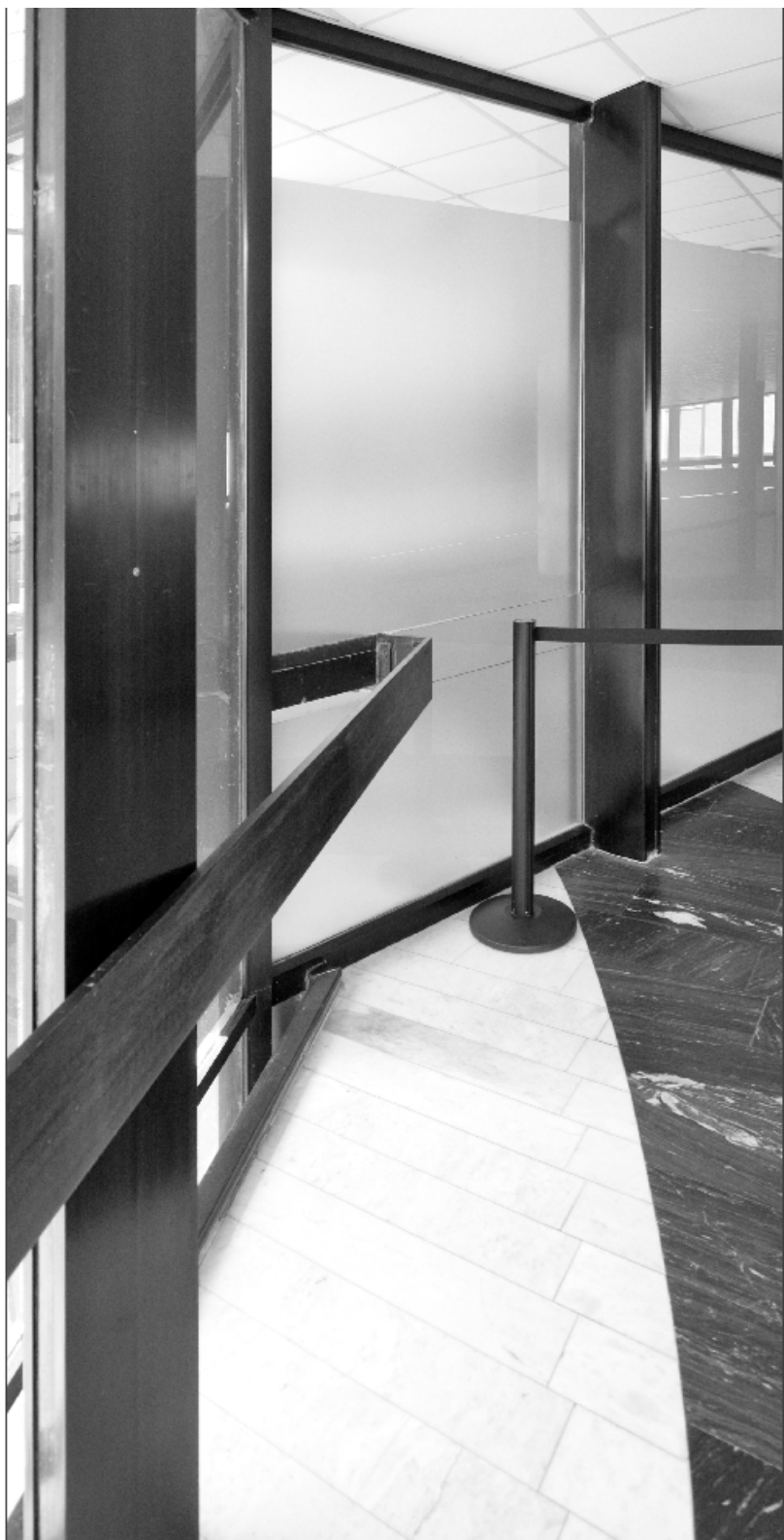
Stěna A-det, 2.NP, pohled z příčné haly Pohled na část prosklení stěny. Madlo a jeho konzola zasahují nevhodně do skleněné výplně, kterou dělí na tři samostatné skleněné části dodatečně upravené ( objemové změny, pohyb ocelové konstrukce vůči stěně ). Jako možné a současné vyhovující řešení se nabízí vložit kolem této konstrukce část nového ocelového rámu konstrukčně nezávislého na konzole a madlu. Zákres tohoto řešení ve dvou variantách představují dva níže nakreslené obrázky dělení stěny.
