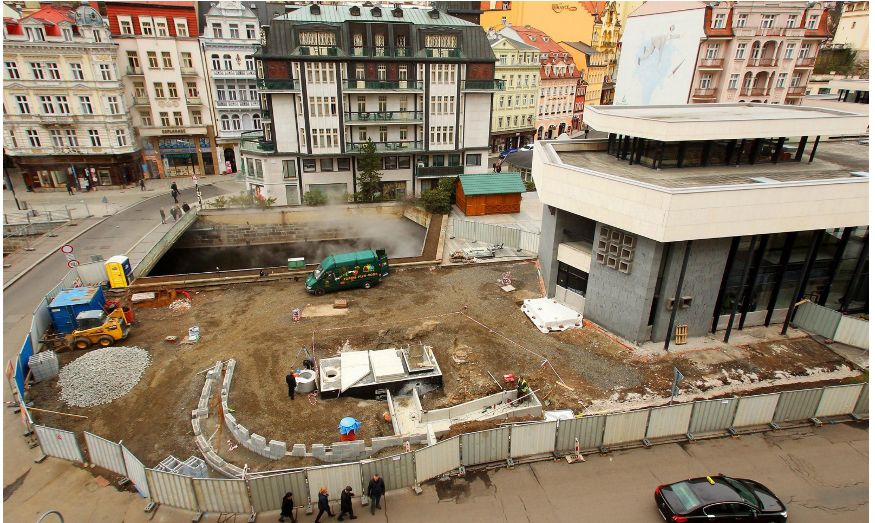
Revizní komora a základy pro betonové schodiště (foto Václav Šlauf, MAFRA, 2016)
