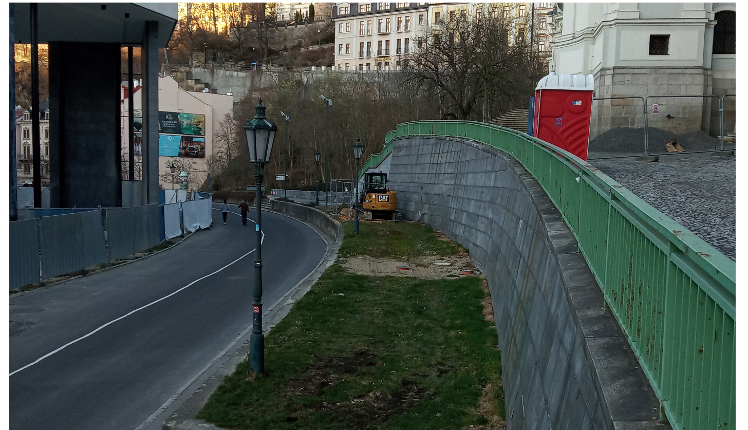
5/ Celkový pohled na řešení paty opěrné zdi - nepřístupná trávnicková plocha
