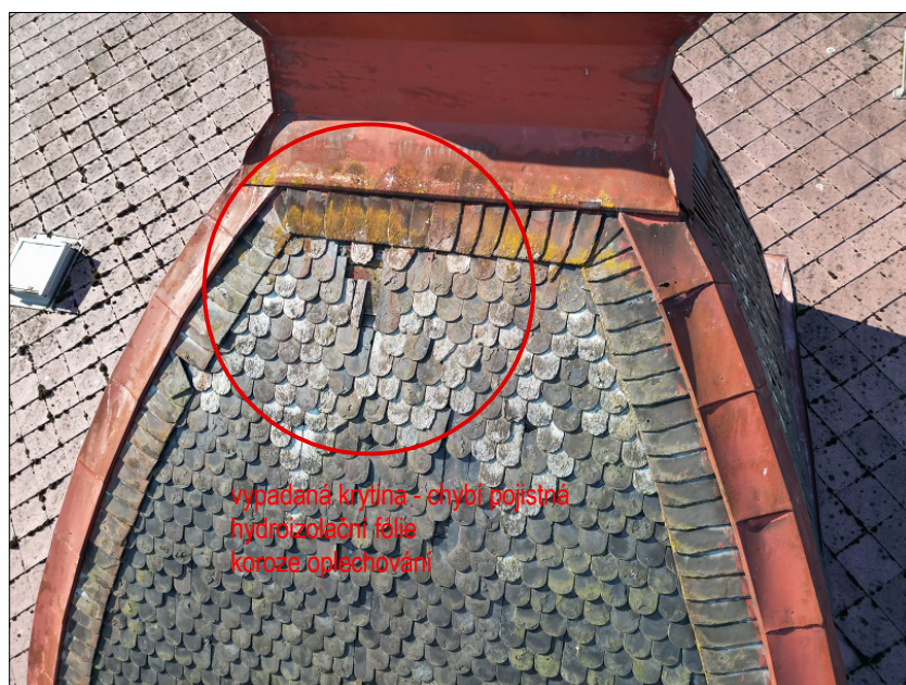
Detail věž - poškození krytiny
