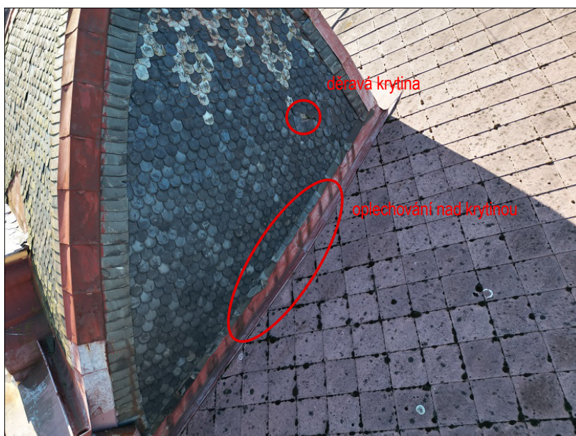
Detail věž - poškození krytiny
