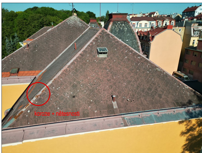
Celkový pohled - korozí oplechování / větrací komínky
