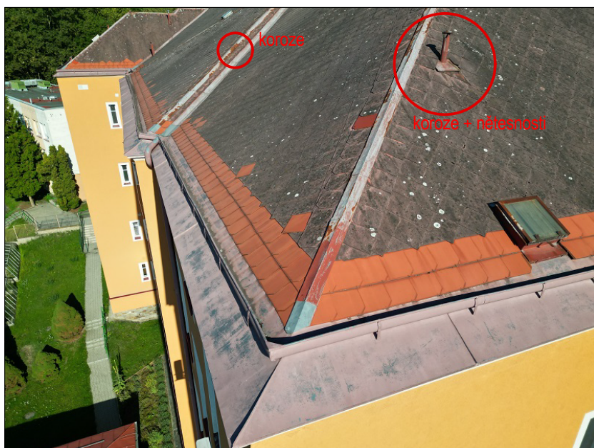
Detail nároží - oprava původní krytiny
