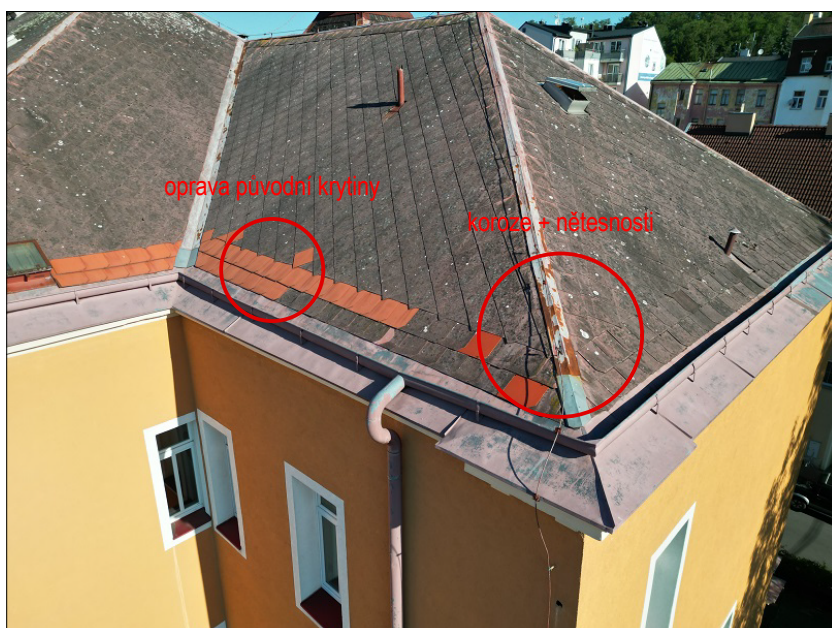
Celkový pohled - korozí oplechování / větrací komínky
