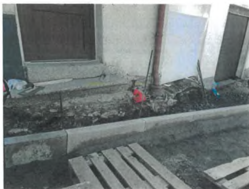
2) Výšková úprava vstupu stan. 0,095km – před osazením schodu z obrub
