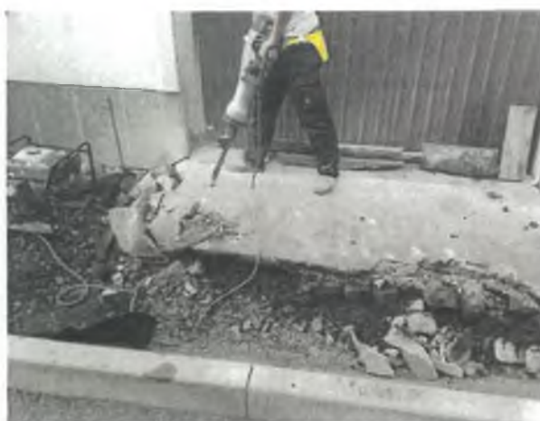
5) 9) řezání + vybourání ŽB podkladu sjezd S15
