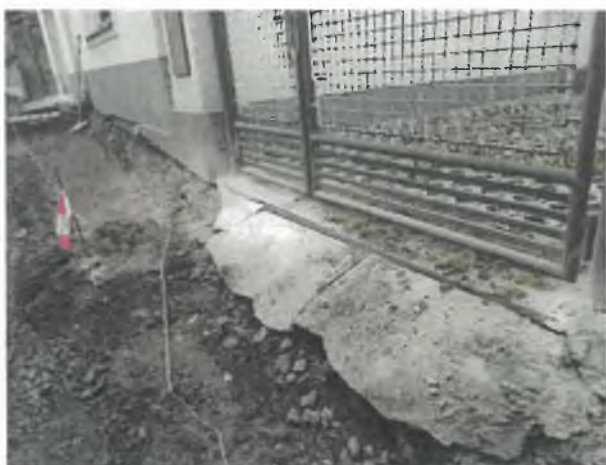
6) 9) řezání + vybourání ŽB podkladu sjezd S14
