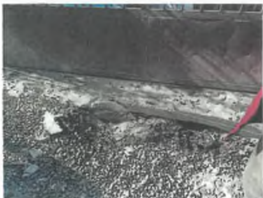
9) Řezání betonu - Sjezd s2 stan. 0,070km
