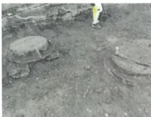
1) vybourání obetonování šachty stan. 0,040km
