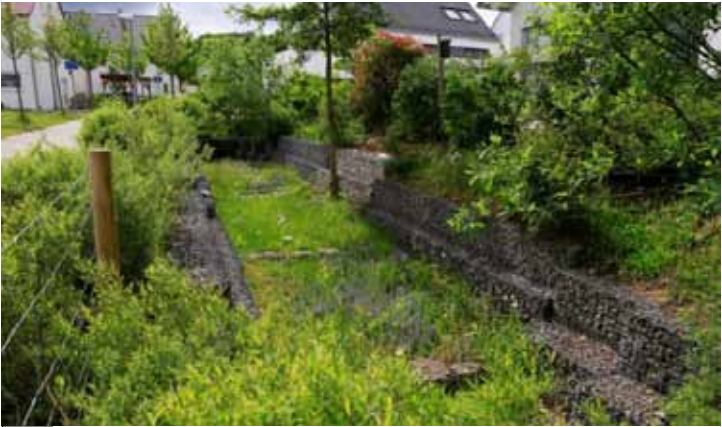
037 Příklad opatření integrovaného do veřejného prostranství – přírodě blízkého odvodnění ulice ve Stuttgartu, kde jsou srážkové vody svedeny do liniového retenčního objektu. Foto: JV PROJEKT VH.
