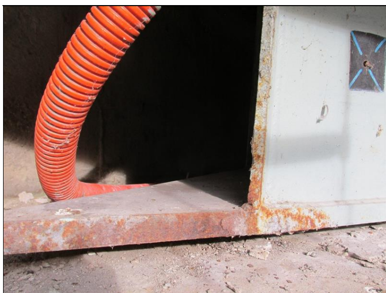
typický detail koroze konců HN
