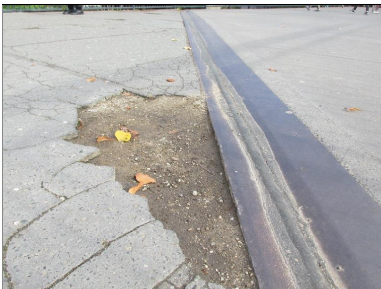
povrchový MZ nad pravobřežní OP1, poruchy krytu
