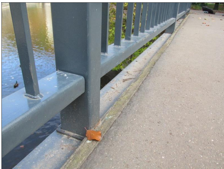
zábradlí na výtoku - po opravě PKO a opravě ukotvení prerezivělých sloupků, nový krycí plech krajů mostovky
