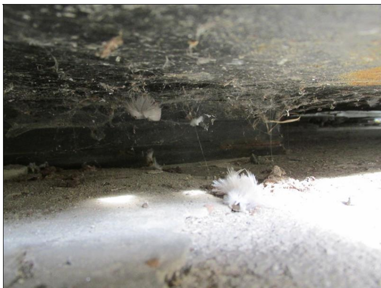
typický detail uložení - elastomer
