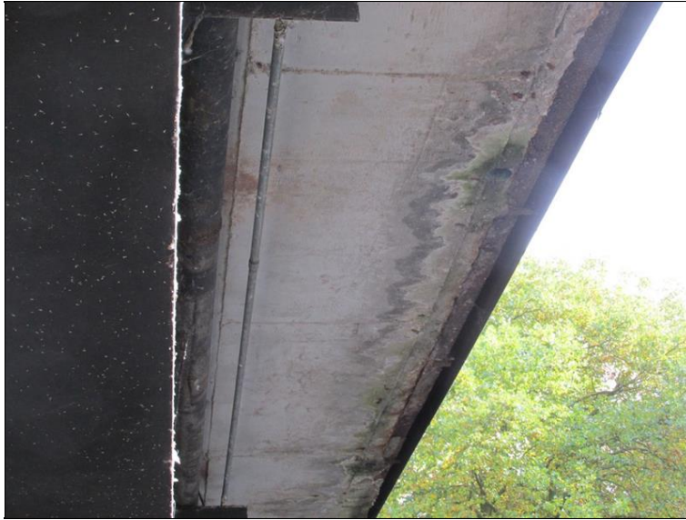
podhled kraje mostovky na výtoku - zatékání s výluhy
