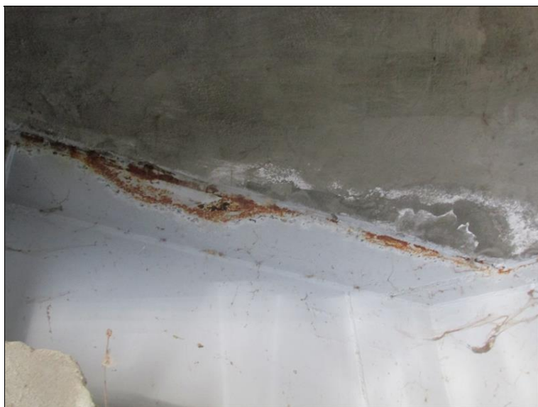
ypický detail koroze koncových příčníků
