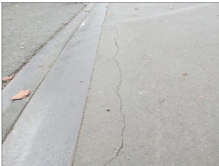
detail trhlin krytu u MZ nad OP2
