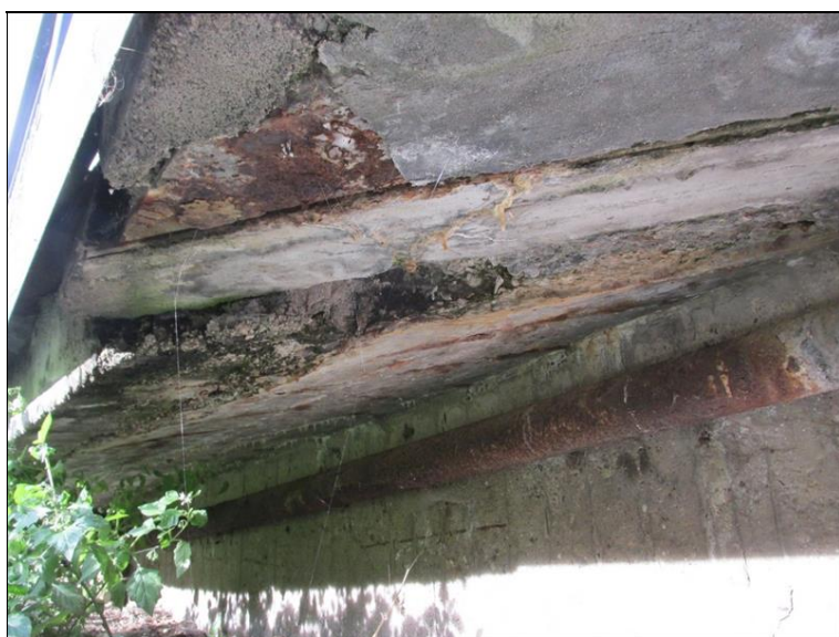
patrný poklesl desky konzolově vyložené mostovky nad pravobřežním křídlem na výtoku (předpolí OP1)
