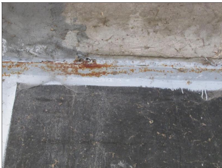
typický detail koroze HN před koncovými nosíky
