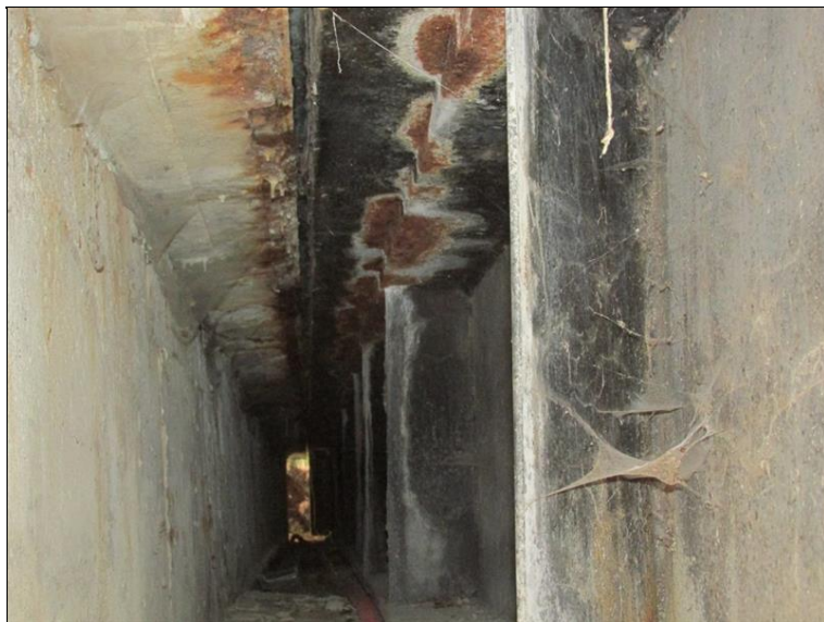
závěrná zídka pravobřežní OP1 - zatékání nefunkčním MZ, koroze koncového příčnicku, zatékání na uložení
