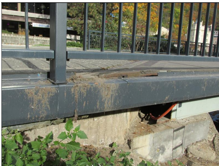
povrchový mostní závěr nad pravobřežní OP1 vpravo - silná degradace betonu v okolí MZ je skrytá pod novým oplechováním
