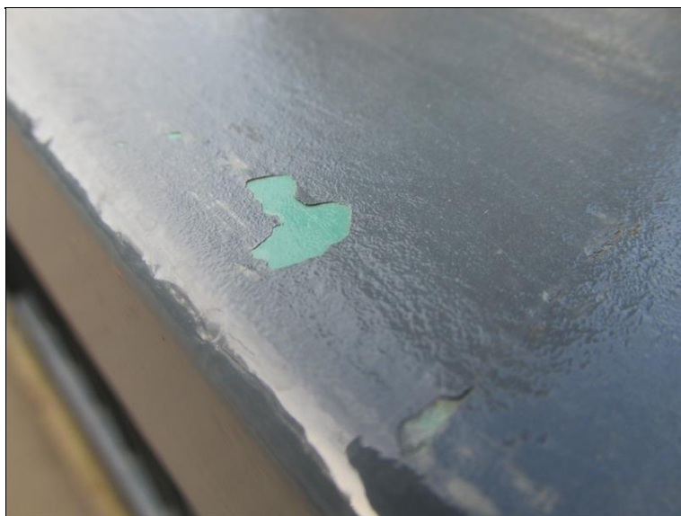
porušené PKO zábradlí na vtoku nad levobřežní OP2
