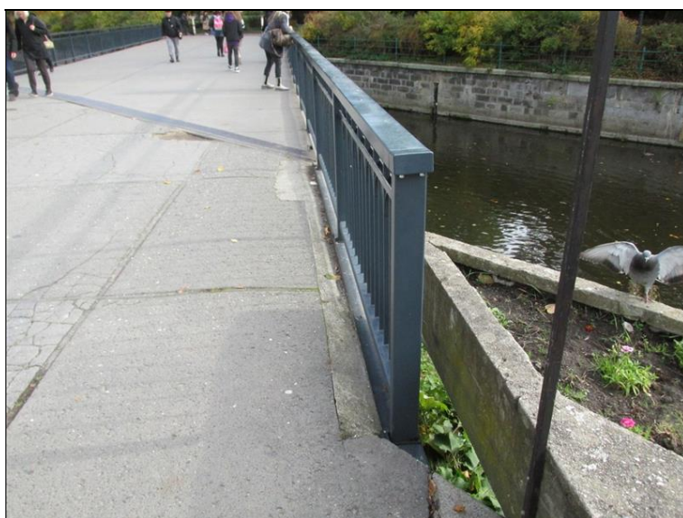
zábradlí na výtoku - po opravě PKO
