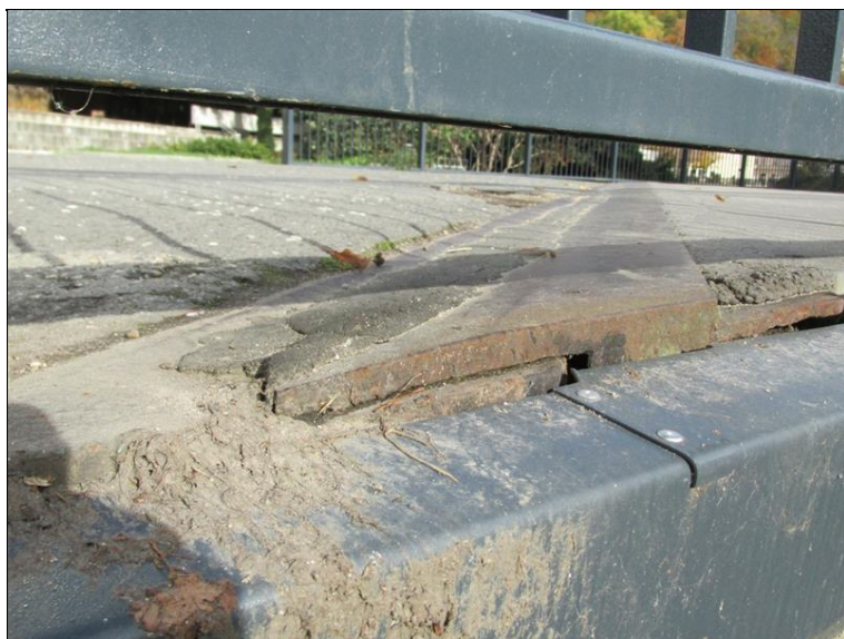
povrchový mostní závěr nad pravobřežní OP1 vpravo
