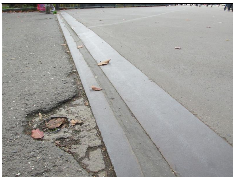
pozůstatek po odstraněných zábranách vjezdu - ostré hrany ve vozovce předpolí před mostním závěrem
