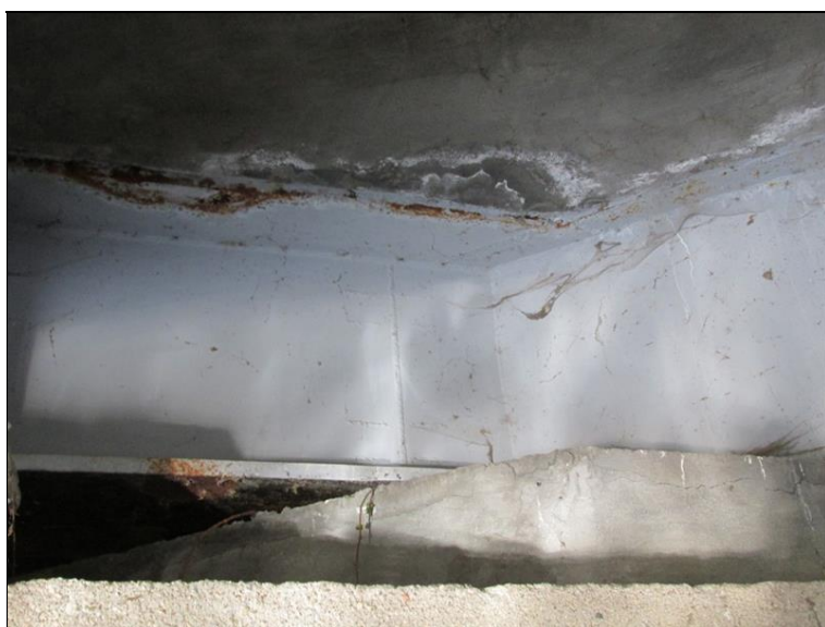
typický detail koroze koncových příčníků
