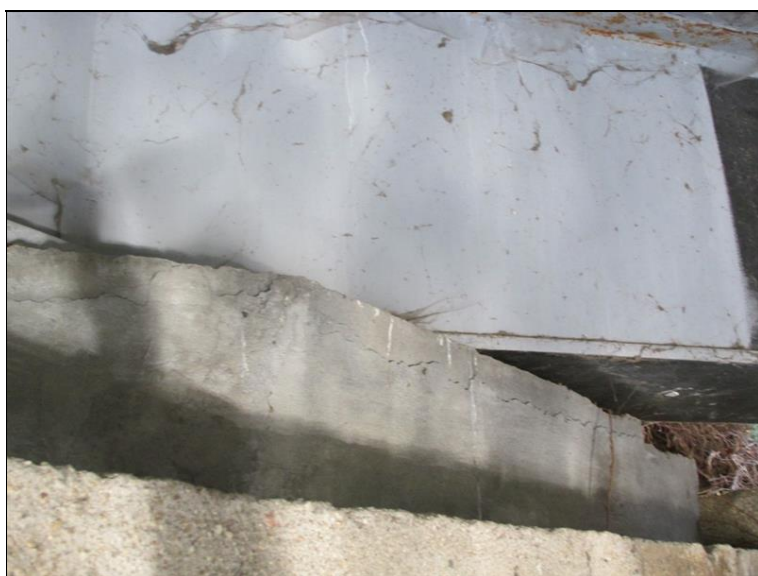
typický detail trhliny v podložiskových blocích
