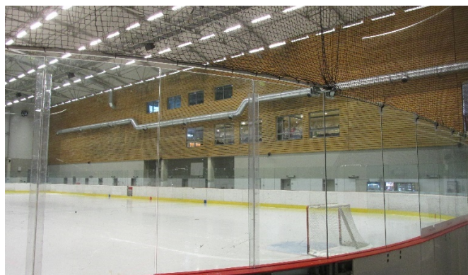
Tréninková hala interiér
