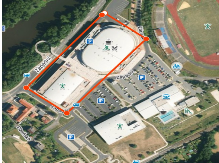
Hlavní požární komplex
