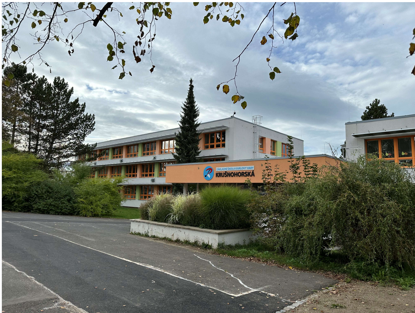
Hlavní vstup – Základní škola Karlovy Vary, Krušohorská 11
