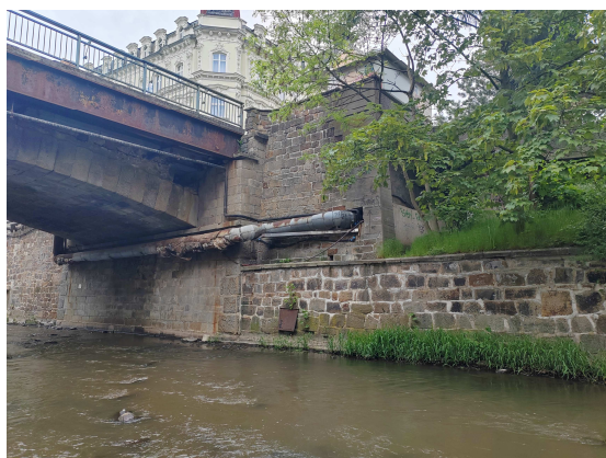
Výstup potrubí do koryta řeky – Poštovní most
