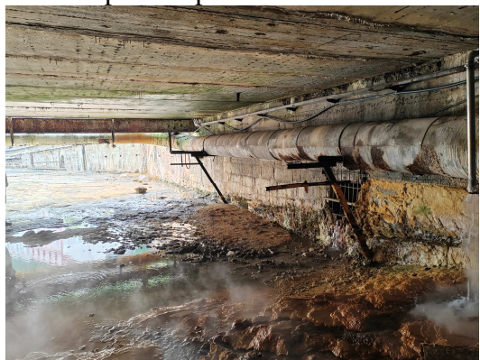
Uložení potrubí pod Vřidelní lávkou
