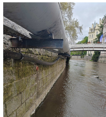
Uložení potrubí na nábrežní zdi řeky
