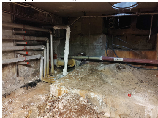
Uložení potrubí pod Vřidelní lávkou
