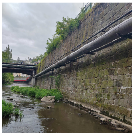
Uložení potrubí na nábrežní zdi řeky
