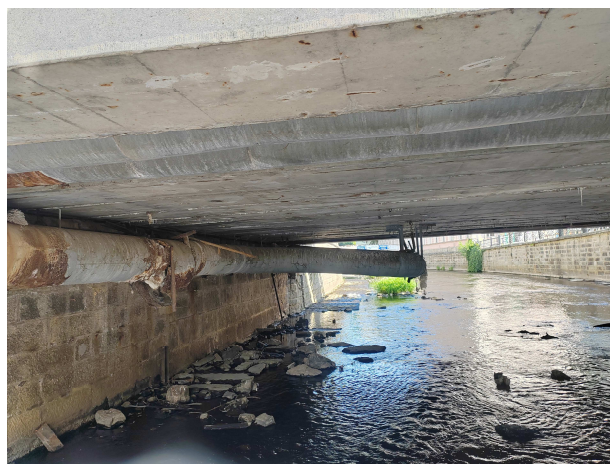
Uložení potrubí na nábrežní zdi řeky
