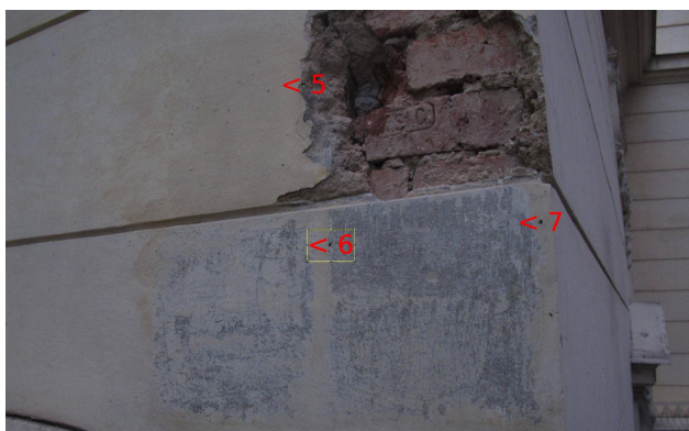
Obr. 22: Stav po provedené zkoušce
